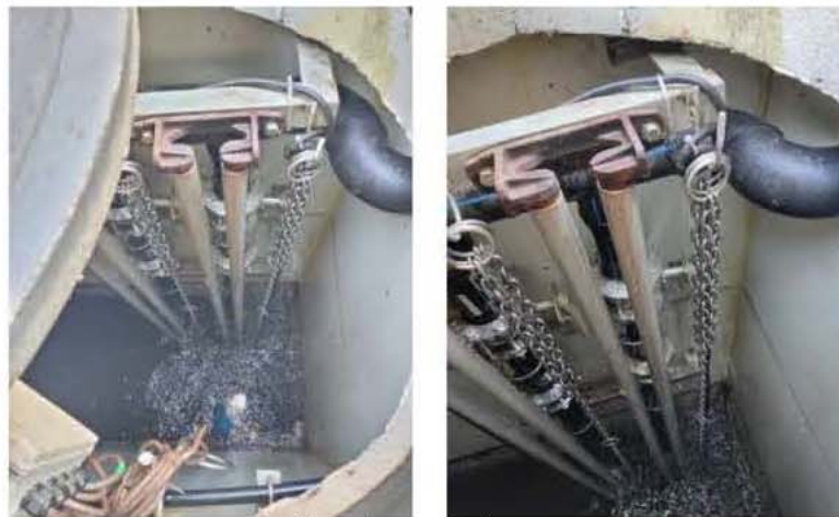
ตรวจสอบท่อทางส่งของปั๊มน้ำออก มีการรั่วบริเวณรอยเชื่อมต่อของท่อ PE
