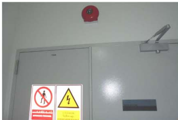
ภาพที่ 3-18 ป้ายเตือนอันตราย และกริ่งสัญญาณดับเพลิงติดไว้หน้าห้องไฟฟ้า
