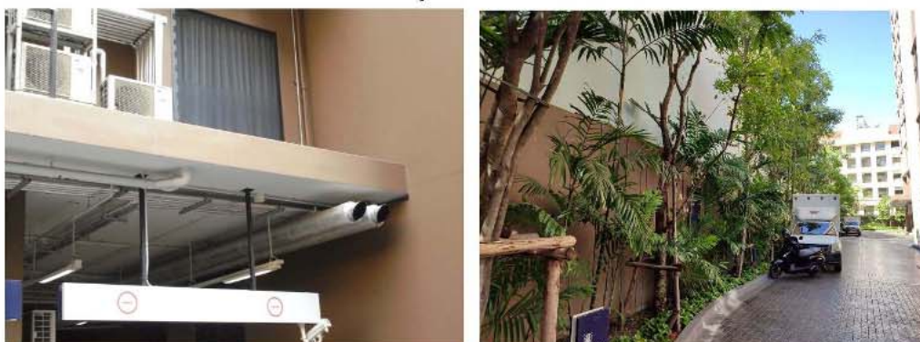
ภาพที่ 3-17 ท่อไอเสียจากห้องไฟฟ้าฉุกเฉิน ปล่อยออกมาตรงกับต้นไม้ยืนต้นข้างรั้วโครงการ
