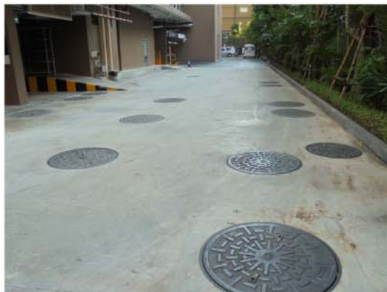
ภาพที่ 3-8 พื้นที่ติดตั้งระบบบำบัดน้ำเสียซึ่งอยู่ใต้ทางวิ่งรถด้านทิศตะวันตก
